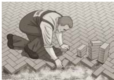
Мощение поверхности с формированием узора «елочка».
