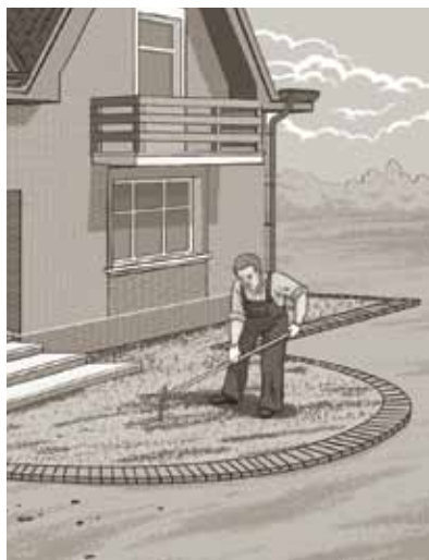
Укладка очередных рядов клинкерной брусчатки.
