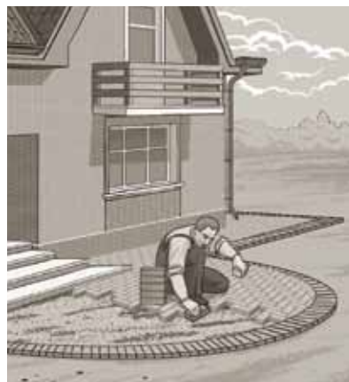
Укладка очередных рядов клинкерной брусчатки.
